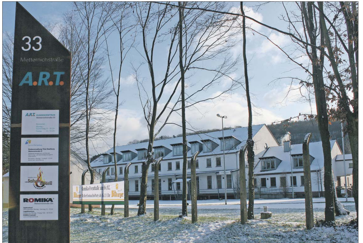
Neuer Standort. Ende nächster Woche bezieht die A.R.T.-Verwaltung ihre neuen Büros in dem umgebauten Gebäude in der Metternichstraße (Trier-Nord). Dort hat ab dem 1. Februar unter anderem das Abfalltelefon seinen Sitz. Foto: PA
