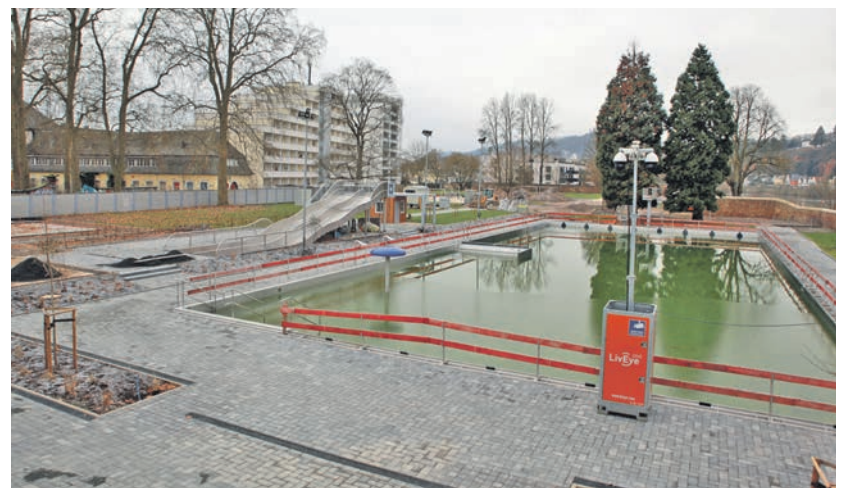
Rundum-Erneuerung. Dieser Blick von der Terrasse des Nordbads während der Sanierung entstand im Januar. Foto: Stadtwerke
