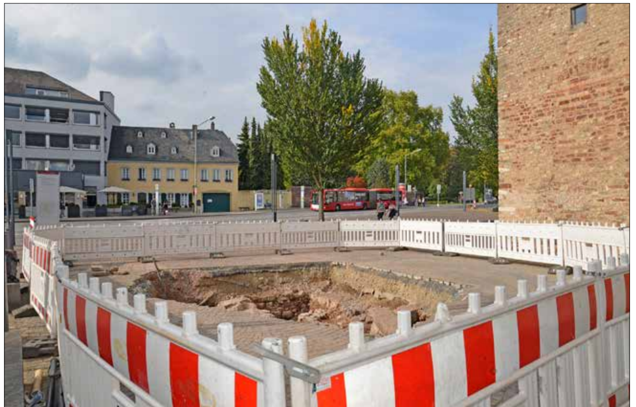
Bereiteter Boden. Die Baustelle für die Errichtung der Karl-Marx-Statue am Simeonstiftplatz ist bereits eingezäunt. Zunächst stand eine archäologische Sondierung des Untergrunds auf dem Programm. Foto: Presseamt
