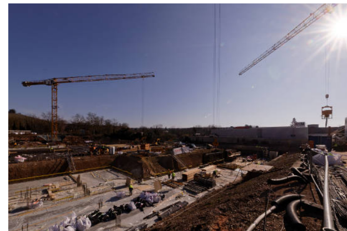
Baugrube. Ein Blick auf die Baustelle lässt die Dimensionen der neuen Hauptwache an der Südallee erahnen. Dort bestimmen derzeit vor allem mehrere große Kräne das Bild.
