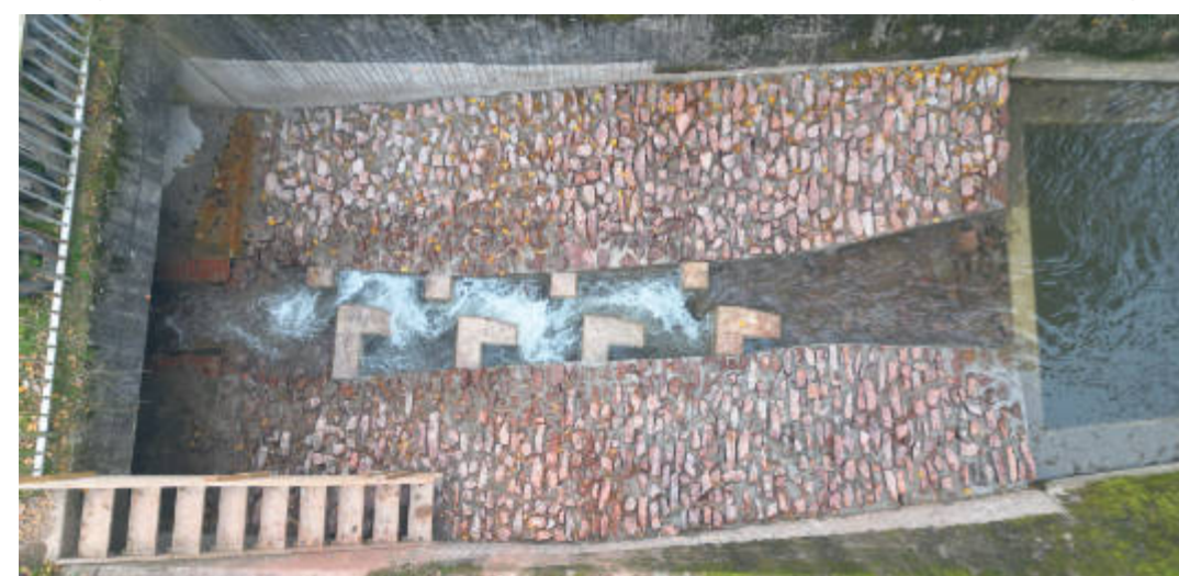
Ökologisch wertvoll. Die neue Fischtreppe aus der Vogelperspektive: An den rechtwinkligen Betonelementen gibt es Stellen ohne eine starke Strömung, wo die Fische sich kurze Ruhepausen während ihres „Aufstiegs“ gönnen. Foto: Firma Astakus
