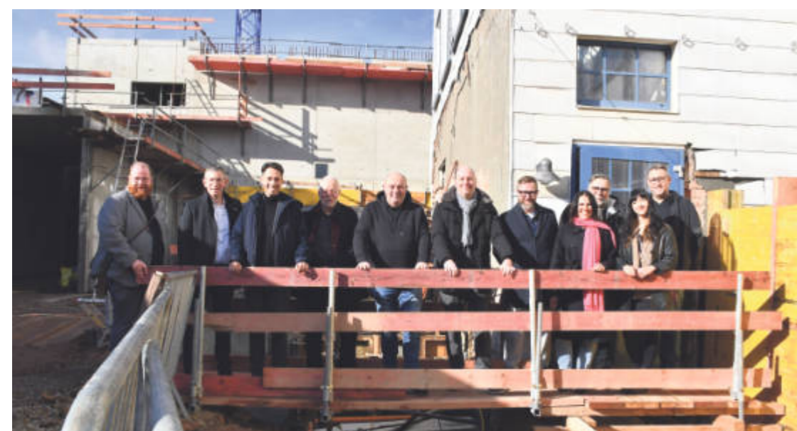
Auf dem Bau. Beteiligte des Tufa-Anbaus von Stadt, Theater, SWT und Tufa, haben sich einen Überblick über den Fortgang der Bauarbeiten verschafft. Foto: Presseamt/heb
