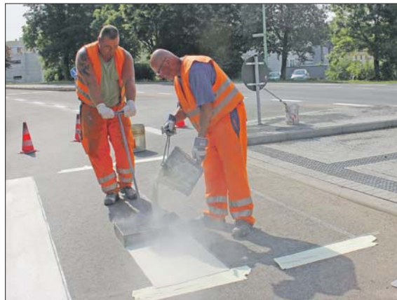
Abschluss. Ein Mitarbeiter einer Baufirma aus Neunkirchen gießt die Kunststoffmasse für die Zebrastrifen auf dem erneuerten Übergang an der Kreuzung Hans-Böckler-Allee/Tessenowstraße. Foto: PA
