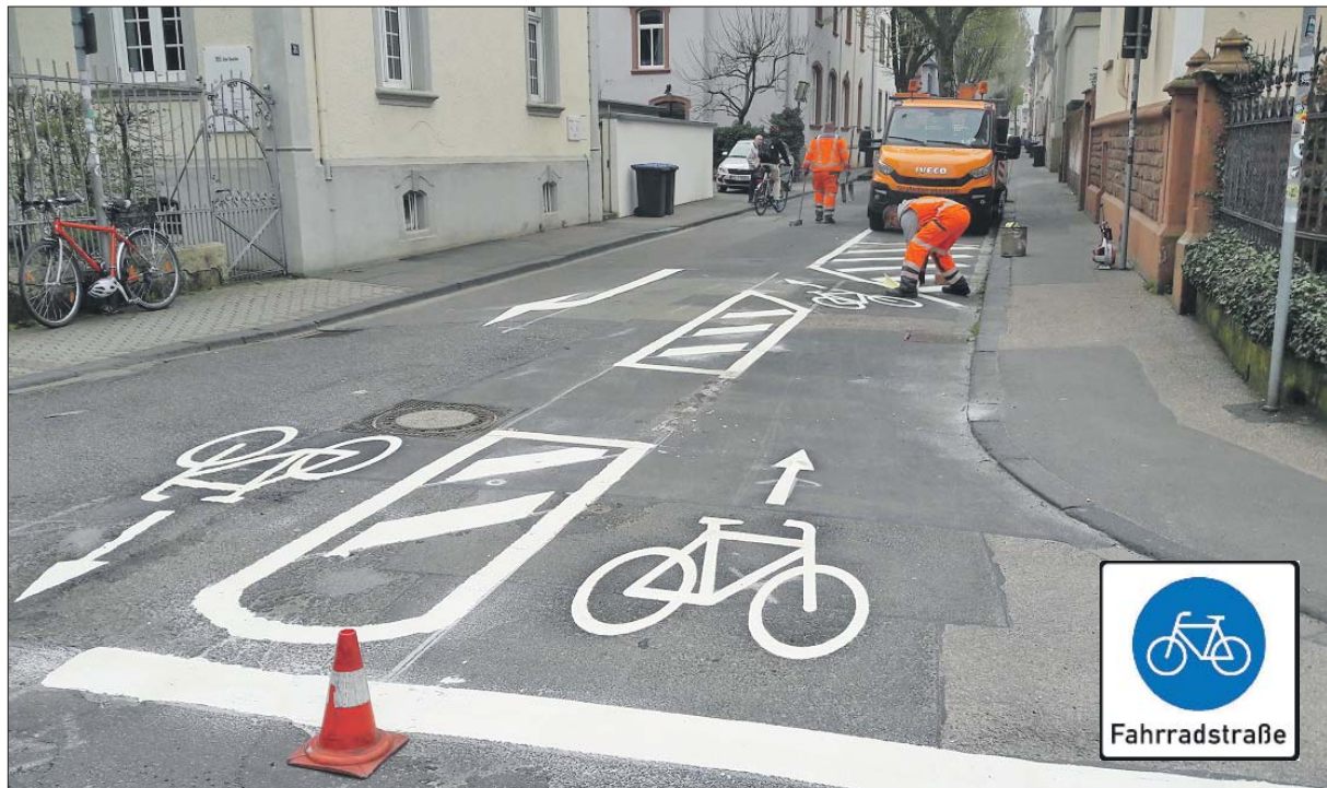
Startpunkt. Als flankierende Maßnahme zur künftigen Beschilderung als Fahrradstraße (kleines Bild) wurden an der Einmündung der Eberhardstraße in die Südallee bereits auffällige neue Markierungen aufgebracht. Foto: Tiefbauamt
