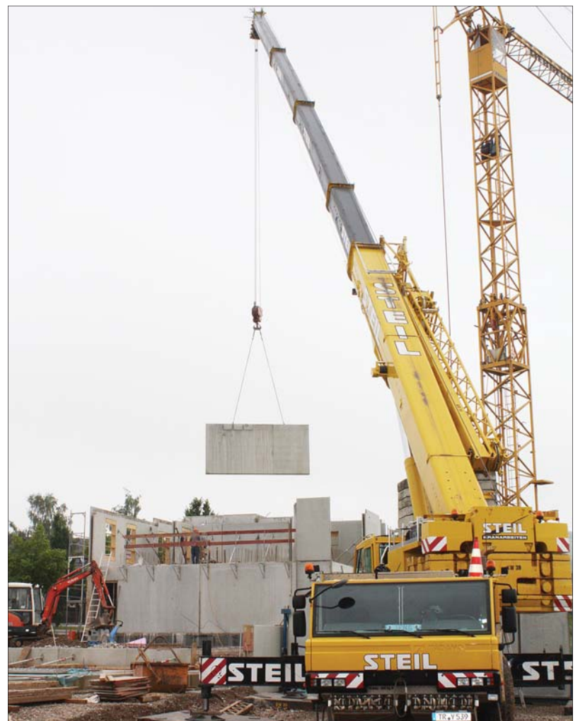
Am Kran. Im Filscher Baugebiet BU 14 schreitet der Rohbau des neuen städtischen Sozialwohnungsprojekts rasch voran. Foto: Presseamt/pe
