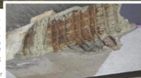
der Stahlbetonkonstruktion haben im Lauf der Zeit dazu geführt, dass der Beton stellenweise abgeplatzt ist, sodass die Stahlelemente frei liegen. Wasser dringt ein und führt zu Korrosion, was wiederum die Substanz der Stahlbewehrung schwächt.“
