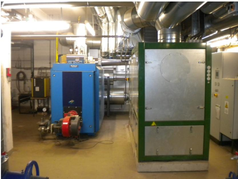
Abbildung 46: Gasspitzenlastkessel links (580 kW<sub>th</sub>), BHKW rechts (207 kW<sub>th</sub>/147 kW<sub>elektr.</sub>)
