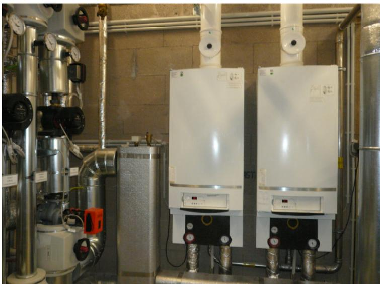
Abbildung 76: Gasbrennwert Wärmeerzeuger
