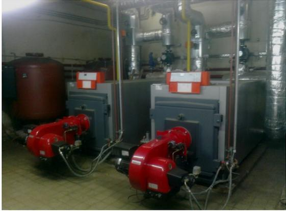
Abbildung 68: Spitzenlastkessel BBS-W
