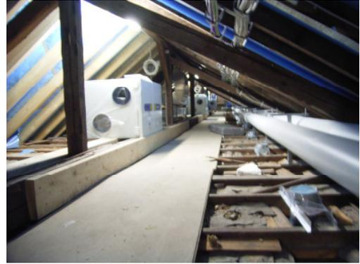
Abbildung 66: Zentrale Lüftungsgeräte (Spitzboden)
