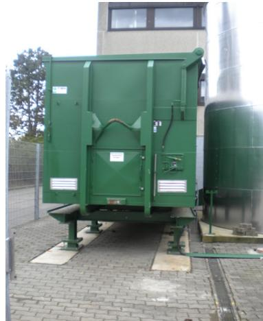
Abbildung 50: Brennstoffcontainer (35m<sup>3</sup>)
