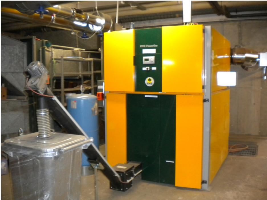
Abbildung 45: Holz hackschnitzelkessel (300 kW<sub>th</sub>)
