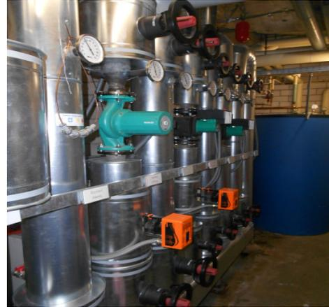
Abbildung 60: Neuer Heizkreisverteiler
