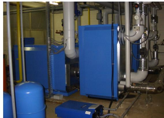
Abbildung 58: Abgaswärmetauscher
