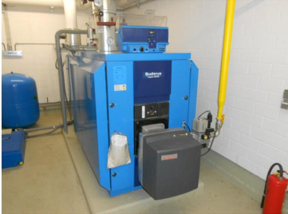
Abbildung 59: Neuer Heizkessel in der Turnhalle
