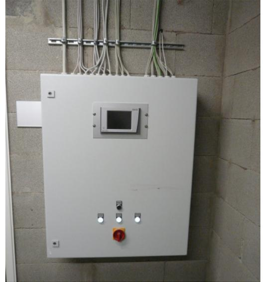
Abbildung 75: Zentrale Regelungseinrichtung
