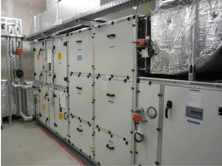
Abbildung 74: Zentrale Lüftungsanlage
