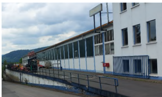
Produktionsgebäude Maschinenfabrik Werner
