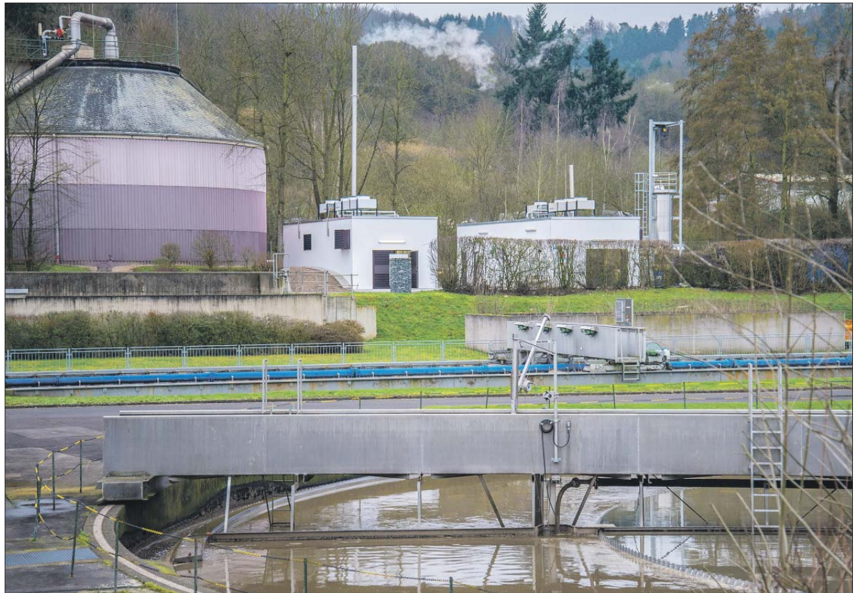
Umwandlung. Die entstehenden Fäulnisgase im Faulbehälter (Foto oben, links), der 2700 Kubikmeter Klärschlamm fasst, werden in den beiden Blockheizkraftwerken in Energie umgewandelt (rechts). Klärwerksleiter Gerd Herrmann kontrolliert den Druck des Kühlwassers (kleines Foto). Fotos: Presseamt
