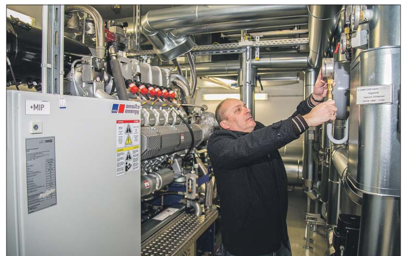
Umwandlung. Die entstehenden Fäulnisgase im Faulbehälter (Foto oben, links), der 2700 Kubikmeter Klärschlamm fasst, werden in den beiden Blockheizkraftwerken in Energie umgewandelt (rechts). Klärwerksleiter Gerd Herrmann kontrolliert den Druck des Kühlwassers (kleines Foto). Fotos: Presseamt
