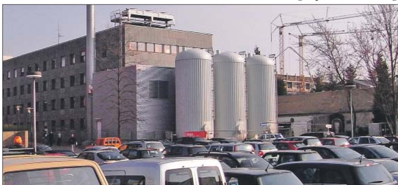
Effizient. Das Blockheizkraftwerk am Mitarbeiterparkplatz des Mutterhauses ist ein wichtiger Energielieferant für die südwestliche Innenstadt. Foto: SWT
