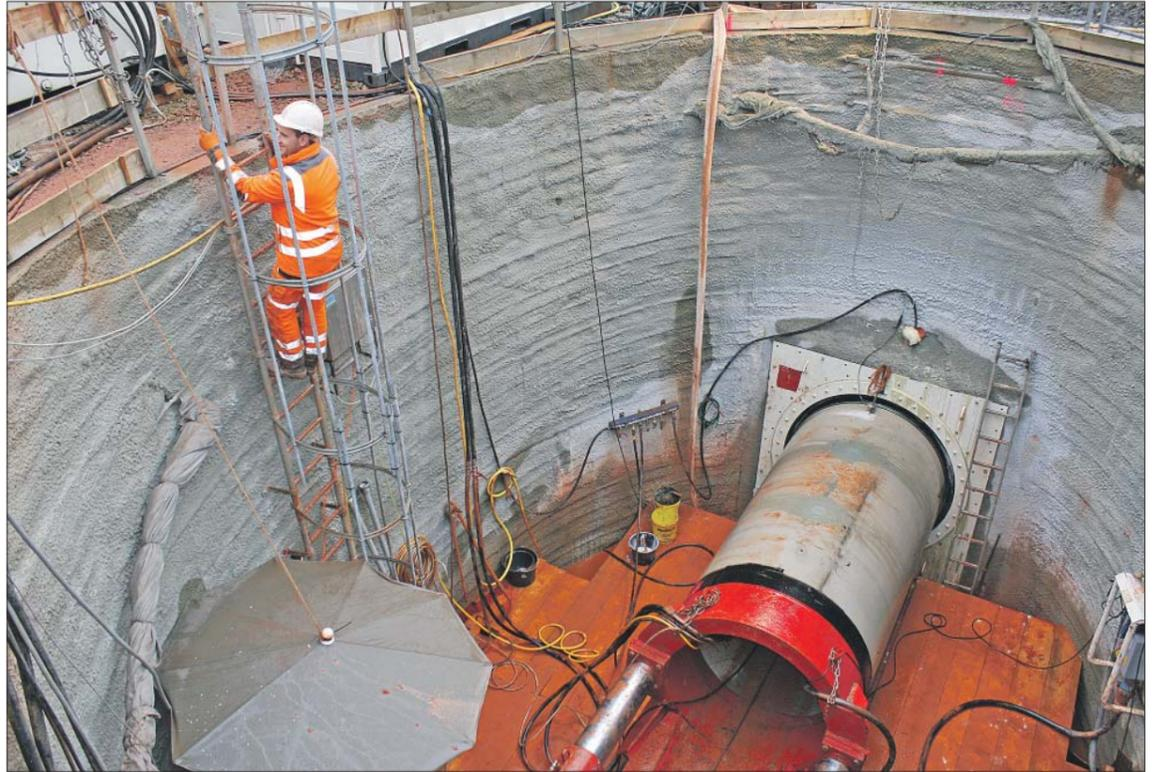
**Abstieg.** David Weiland von der mit dem Rohrvortrieb beauftragten Firma Sonntag klettert in die mit Spritzbeton verkleidete Startgrube. Die Vortriebsmaschine (rechts) arbeitet sich Stück für Stück zum Endpunkt. *Foto: PA/kip*
