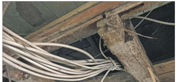
**Baufällig.** Ein tragender Balken im Exhaus-Gebäude ist stark verkohlt, weswegen die Statik beeinträchtigt ist (Foto l.). Teilweise kommen die Schäden erst unter abgehängten Decken zum Vorschein (Foto oben r.) und einige – für die Statik wichtige – Balken sind einfach abgesägt worden, um Platz zu schaffen (Foto unten r.). Fotos: Gebäudewirtschaft; PA/mic
