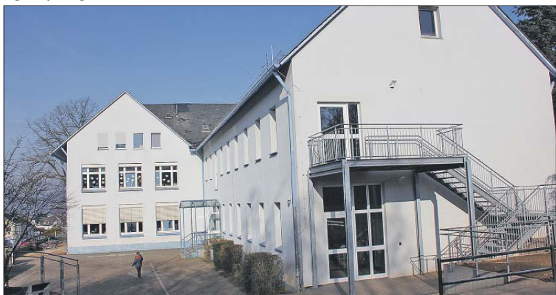
Ausbau. Das Gelände der Grundschule im Stadtteil Feyen-Weismark wird sich in den nächsten Jahren grundlegend verändern. Das Schulgebäude wird vergrößert und in der Nachbarschaft entsteht der Kita-Neubau. Foto: PA
