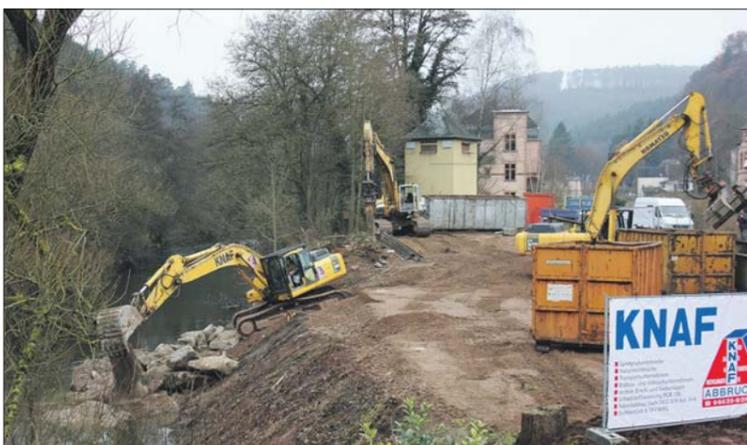
Die Umgestaltung des früheren Mühlengeländes in Ehrang macht sichtbare Fortschritte. Die längst nicht mehr genutzte Bahnbrücke über die Kyll wurde letzten Mittwoch abgebrochen. Am Tag danach entfernte ein Bagger die Pfeiler (links). Gleichzeitig wurden Brückenelemente zerkleinert (rechts). Foto: PA
