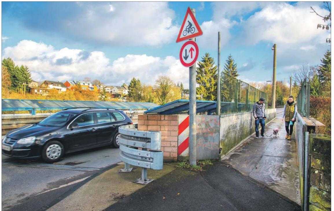
**Spaziergang.** Die Fußgängerbrücke an der Aulstraße stammt aus dem Jahr 1978. Wegen starker Rostschäden an der Unterseite muss der Überbau entfernt und durch eine Alukonstruktion ersetzt werden. *Foto: Presseamt*
