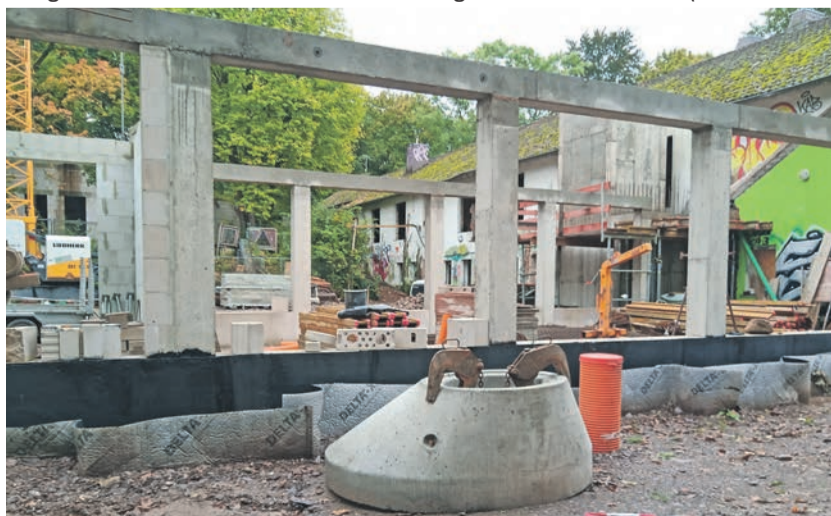
Neubau. Die Errichtung des künftigen Mehrzweckraums ist ein Schwerpunkt der Erneuerung der Egbert-Grundschule. Foto: Hochbauamt
