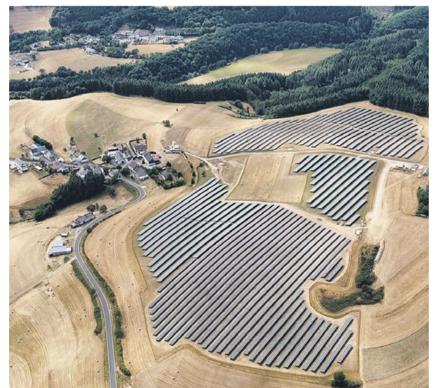
Dezentral. Die neuen Photovoltaikanlagen in der Südeifel sind auf insgesamt sechs Parks verteilt, darunter in der Nähe von Affler. Foto: Stadtwerke
