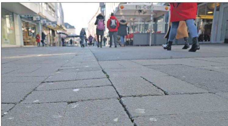
**Stolperfallen.** Durch die stärkere Ausprägung der Fahrspur im Pflaster vergrößern sich teilweise die Kanten zwischen den Steinen. *Foto: PA/gut*
