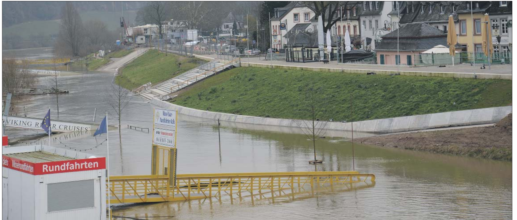
Über dem Ufer. Die Stabilisierung des Hochwasserschutzdamms am Zurlaubener Ufer ist ein Großprojekt des städtischen Tiefbauamts. Der erste Bauabschnitt soll in diesem Jahr fertiggestellt werden. Vor Hochwasser – wie es aktuell eines gibt – sind die Anwohner dann besser geschützt. Foto: Presseamt/pe
