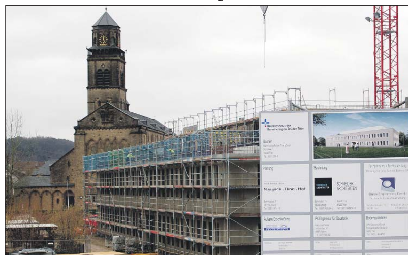
Alt und Neu. Das Bildungszentrum entsteht in der Nachbarschaft der Kirche St. Martin im Maarviertel. Sie wurde zwischen 1912 und 1915 als dreischiffige neuromanische Basilika errichtet. Foto: Bräderkrankenhause
