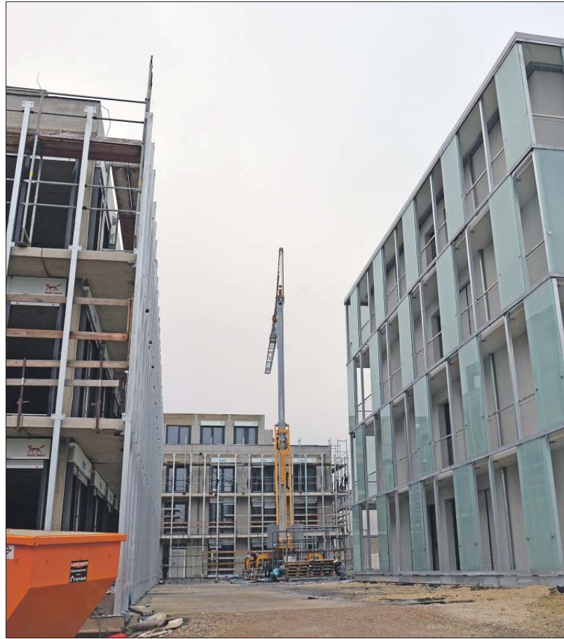
Hochgezogen. Unter dem Namen „Residenz an den Kaiserthermen“ errichtet die Firma Beda Regiebau vier Gebäude mit Eigentumswohnungen an der Charlottenstraße. Die Bodenrichtwerte für Wohnbau land in Zentrumsnähe gehen weiter nach oben. Foto: PA/pe
