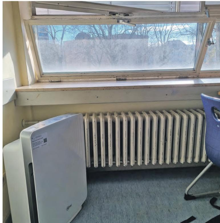
**Kombi-Lösung.** In diesem HGT-Klassenzimmer wurde ein Luftreinigungsgerät aufgestellt, weil die Lüftung durch die Fenster nicht ausreicht. Foto: PA/pe
