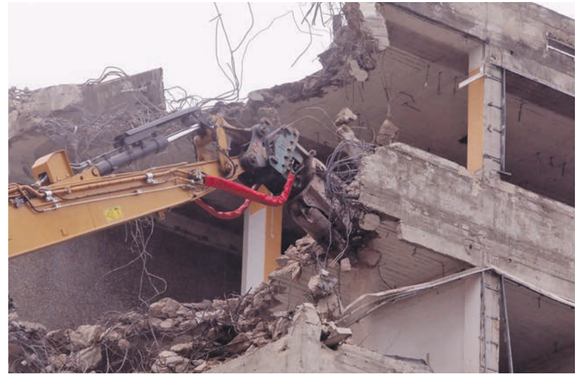
Geschoss für Geschoss. Die Betonscheren am Arm eines Abrissbaggers fressen sich in die entkernte Hülle des alten Polizeipräsidiums und reißen dieses ab. Fotos: Presseamt/em
