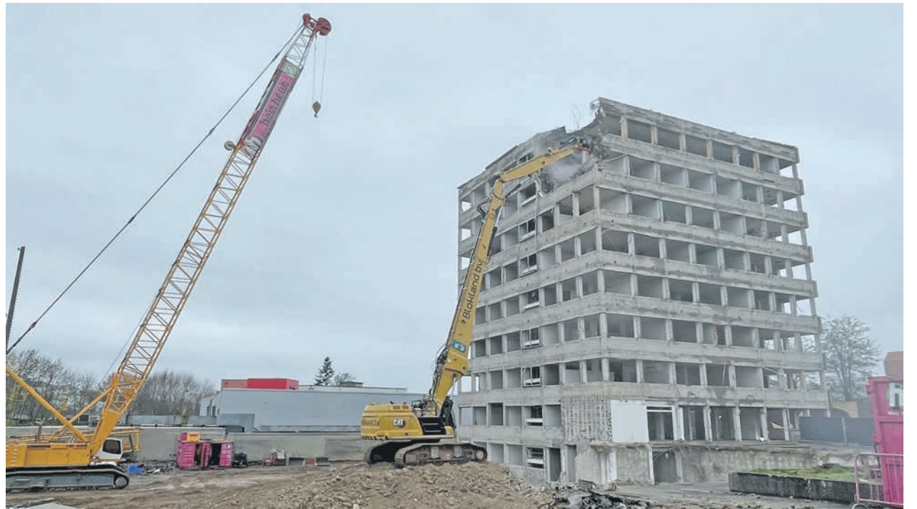
Geschoss für Geschoss. Die Betonscheren am Arm eines Abrissbaggers fressen sich in die entkernte Hülle des alten Polizeipräsidiums und reißen dieses ab. Fotos: Presseamt/em
