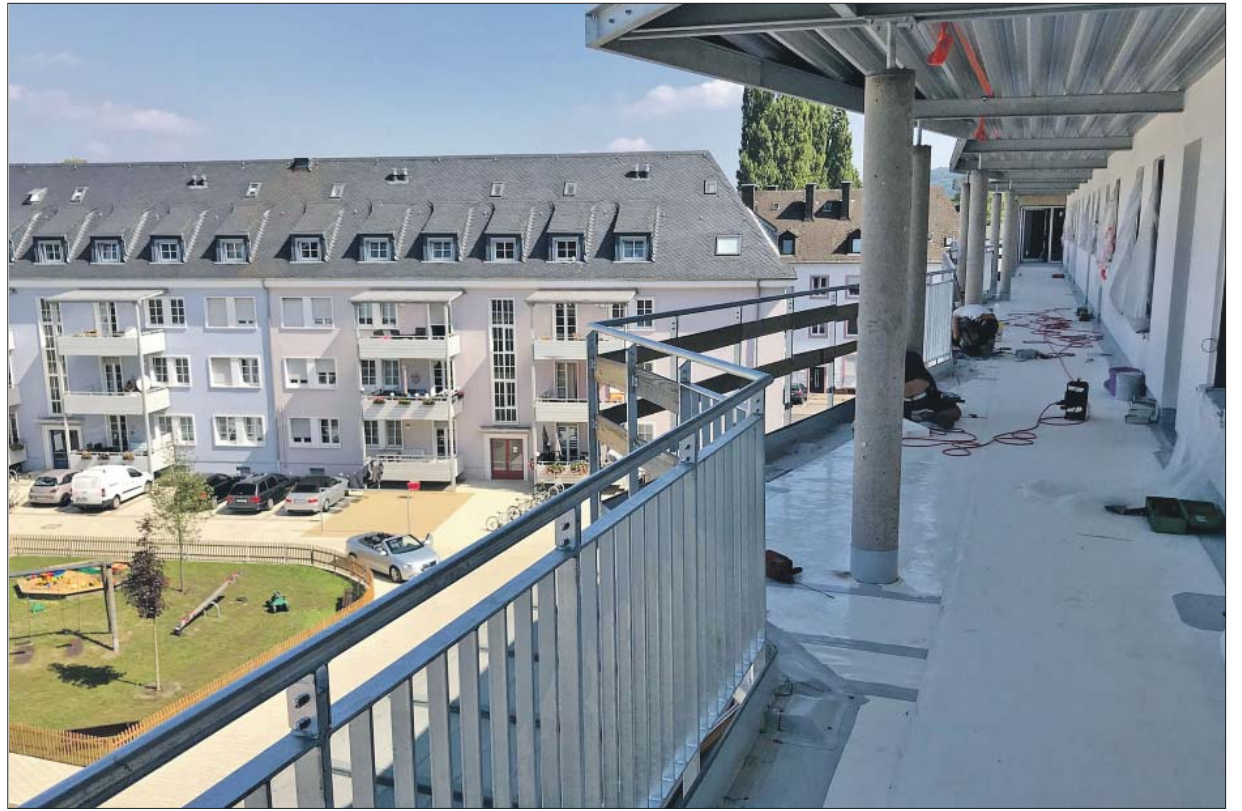
Neubau. In dem noch nicht ganz fertiggestellten Komplex „Wohnen im Quartier“ der Wohnungsgenossenschaft Beutelweg (Wogebe) in Trier-Nord sind alle Wohnungen durch Laubengänge in Kombination mit Aufzügen für Rollstuhlfahrer und Gehbehinderte zugänglich. Das Foto entstand im Sommer. Von den 37 Wohnungen der Anlage sind 32 öffentlich gefördert. Davon werden 27 für sechs Euro pro Quadratmeter vermietet und fünf für sieben Euro. Archivfoto: Wogebe
