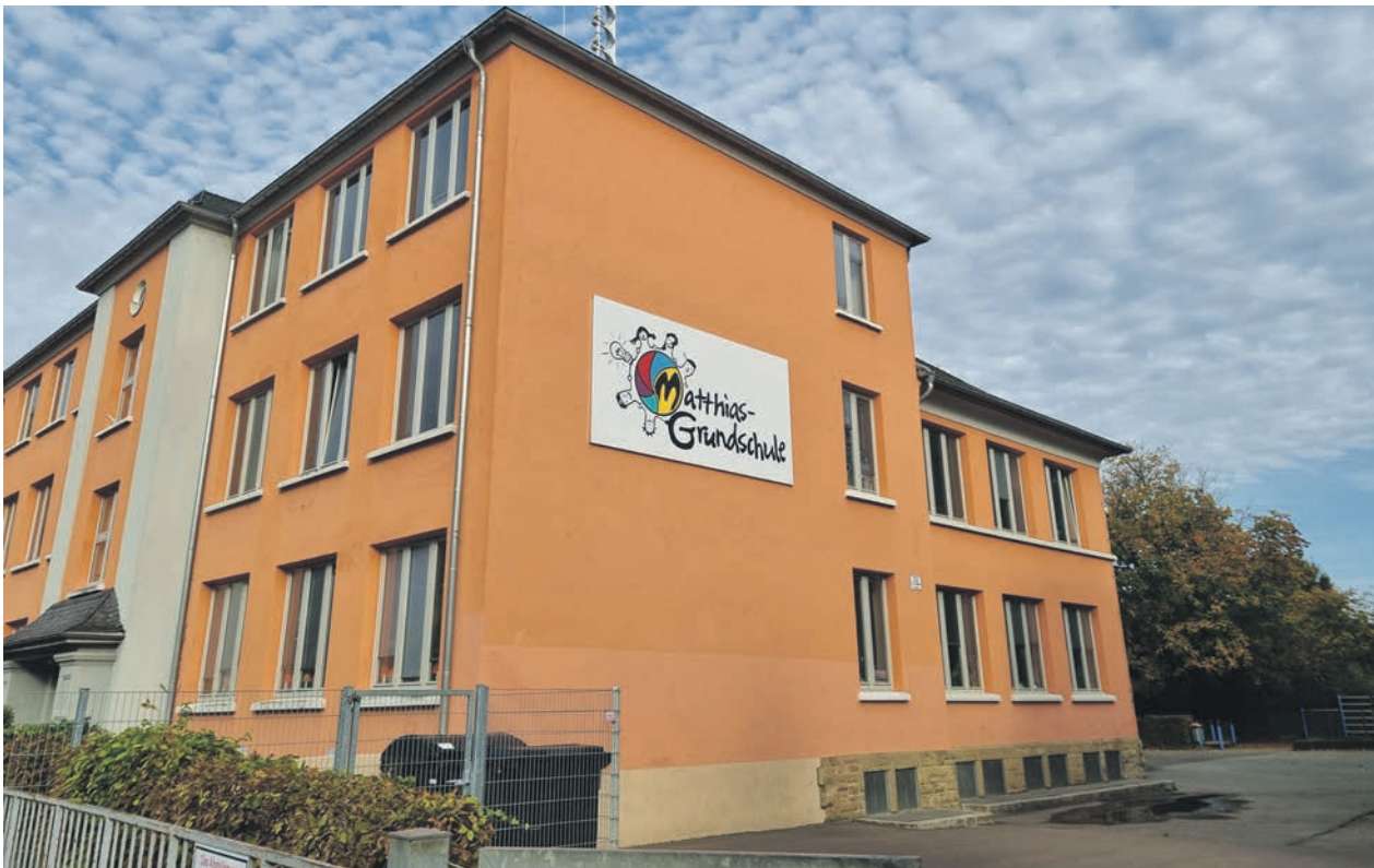
Zwischenlösung. Die Container für das Mittagessen werden im hinteren Teil des St. Matthias-Schulhofs in Trier-Süd (rechts im Bild) aufgestellt. Foto: Presseamt/pe
