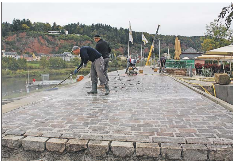
Rausgeputzt. Die Natursteinpflasterung des Deichkronenwegs trägt zum neuen Ambiente rund um die Terrassenrestaurants in Zurlauben bei. Foto: PA
