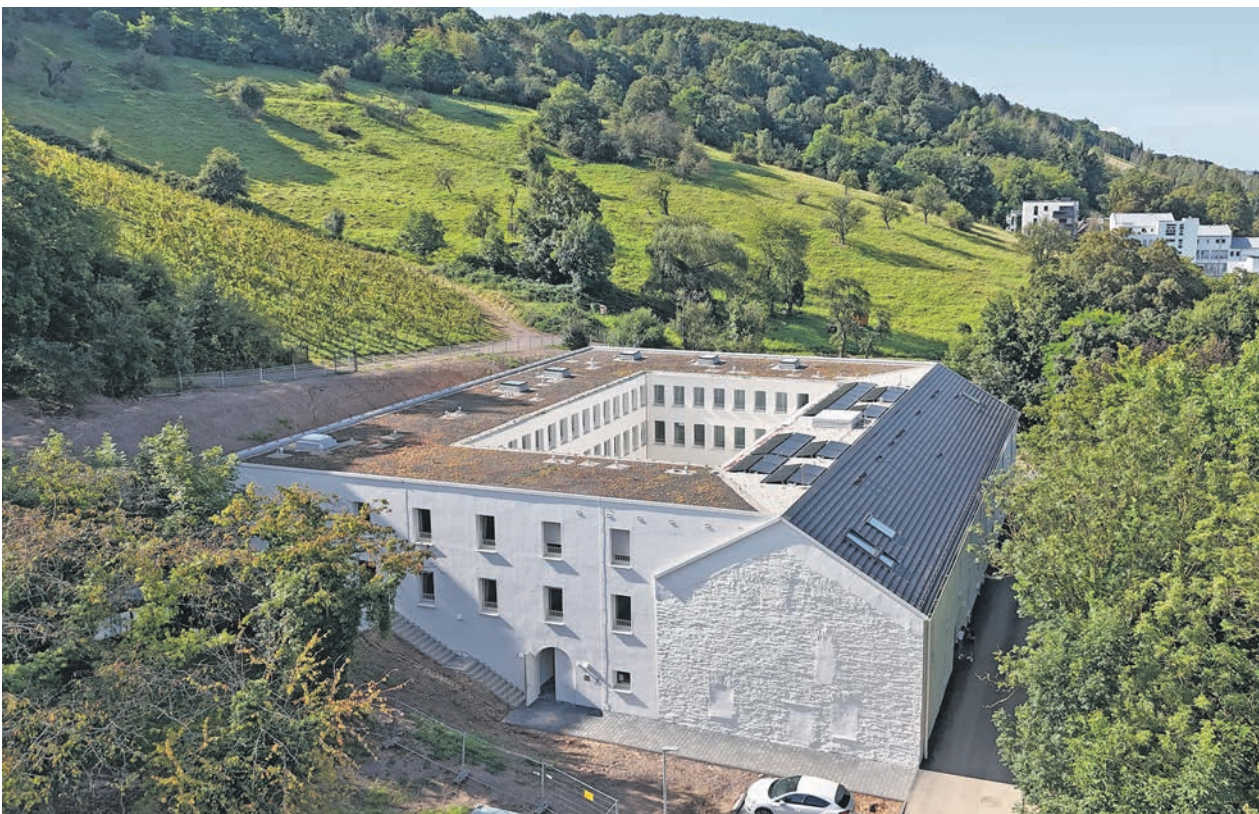
Domizil. Das sanierte und erweiterte frühere Ökonomiegebäude des Klosters wurde am Fuß des Petrisbergs in den Hang gebaut und bildet den ersten Bauabschnitt des Projekts Bethanien. Fotos: gbt
