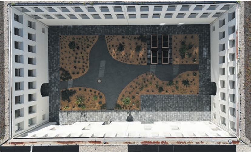
Karree. Blick in den Innenhof des fertiggestellten Kloster- und Wohngebäudes.
