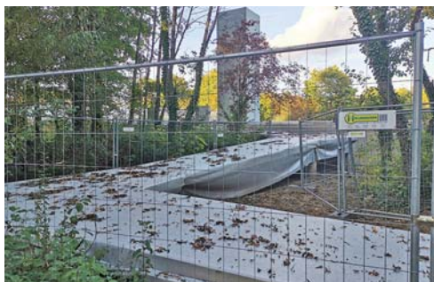
Zwangspause. Blick auf die verwaiste Kita-Baustelle in Pfalzel. Foto: UBT/Sarah Lorenz
