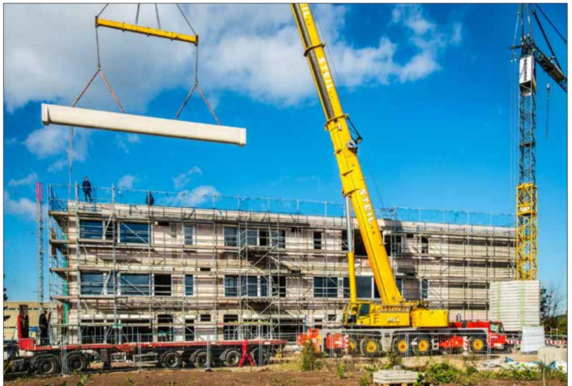
**Schwere Last.** Der letzte von sechs Stahlbetonbindern wird mit einem Schwerkran über den ehemaligen offenen Innenhof auf das Dach der IGS gehoben. In die 12,50 Meter langen und circa einen Meter hohen Teile werden später die Oberlichtmodule gesetzt, die dann einen überdachten und regendichten Innenraum schaffen. Foto: Presseamt
