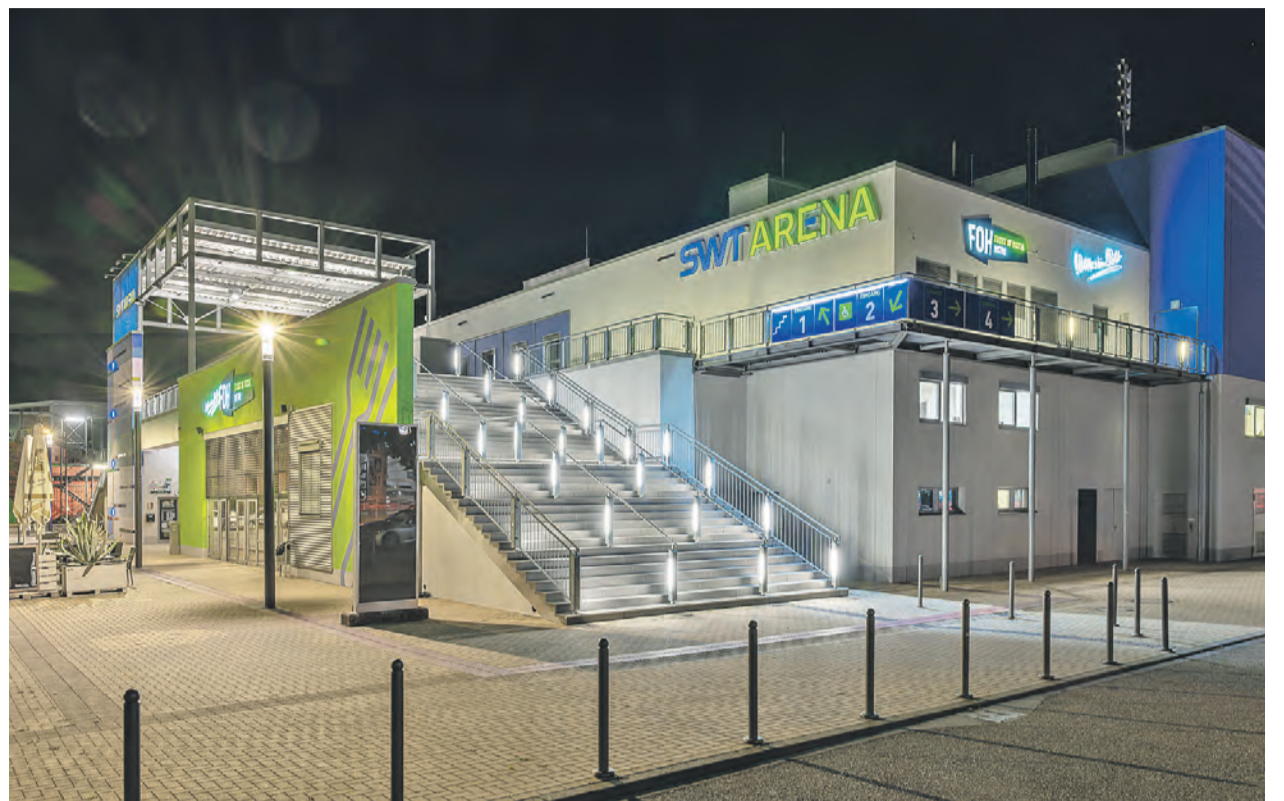
Zugang. Der neue Namenszusatz der Trierer Multifunktionshalle ist an der instandgesetzten Fassade auch in den Abendstunden gut sichtbar. Foto: Simon Engelbert
