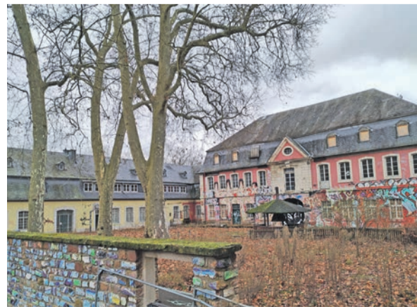
Verlassen. Zu einem Bürgerbegehren über die Sanierung des Exhaus-Gebäudes an der Zurmaier Straße kommt es vorerst nicht. Archivfoto: Presseamt
