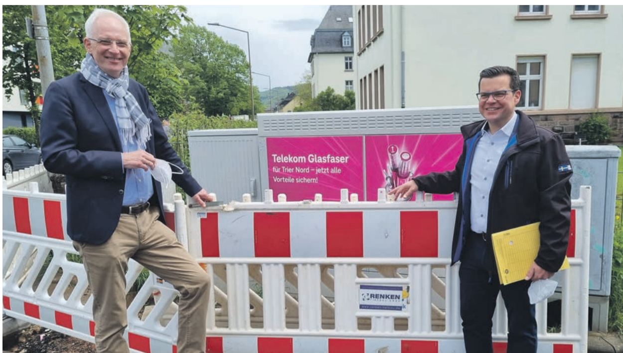
Schnelle Leitung. OB Wolfram Leibe (links) und Chief Digital Officer Thorsten Kraus begutachten bei einem Ortstermin in Trier-Nord die Bauarbeiten zur Verlegung von Glasfaser. Eine gute Internetanbindung ist die Basis für den Aufbau von digitalen Angeboten. Archivfoto: Presseamt/pe
