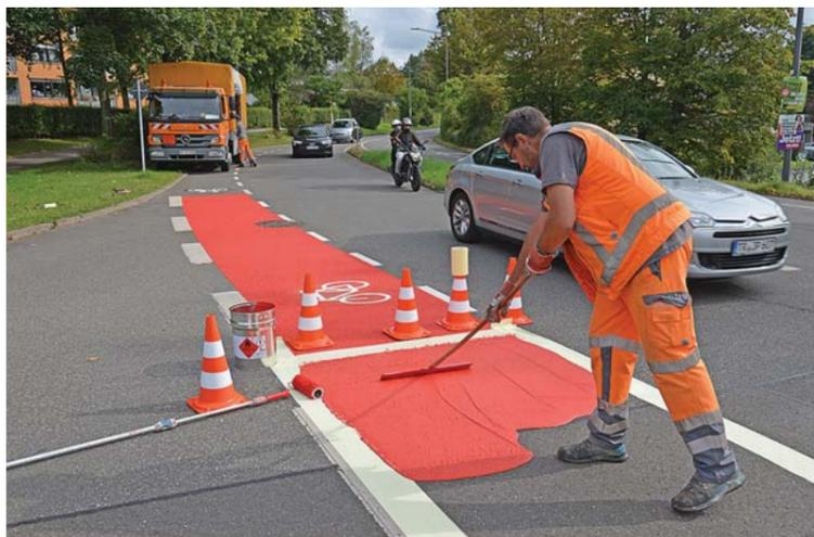
**Verkehrsröt.** Ein Mitarbeiter der Firma Meiser Fahrbahnmarkierung aus Quierscheid verteilt frische Farbe über eine Radverkehrsfurt in der Hans-Böckler-Allee. Foto: Presseamt/kig
