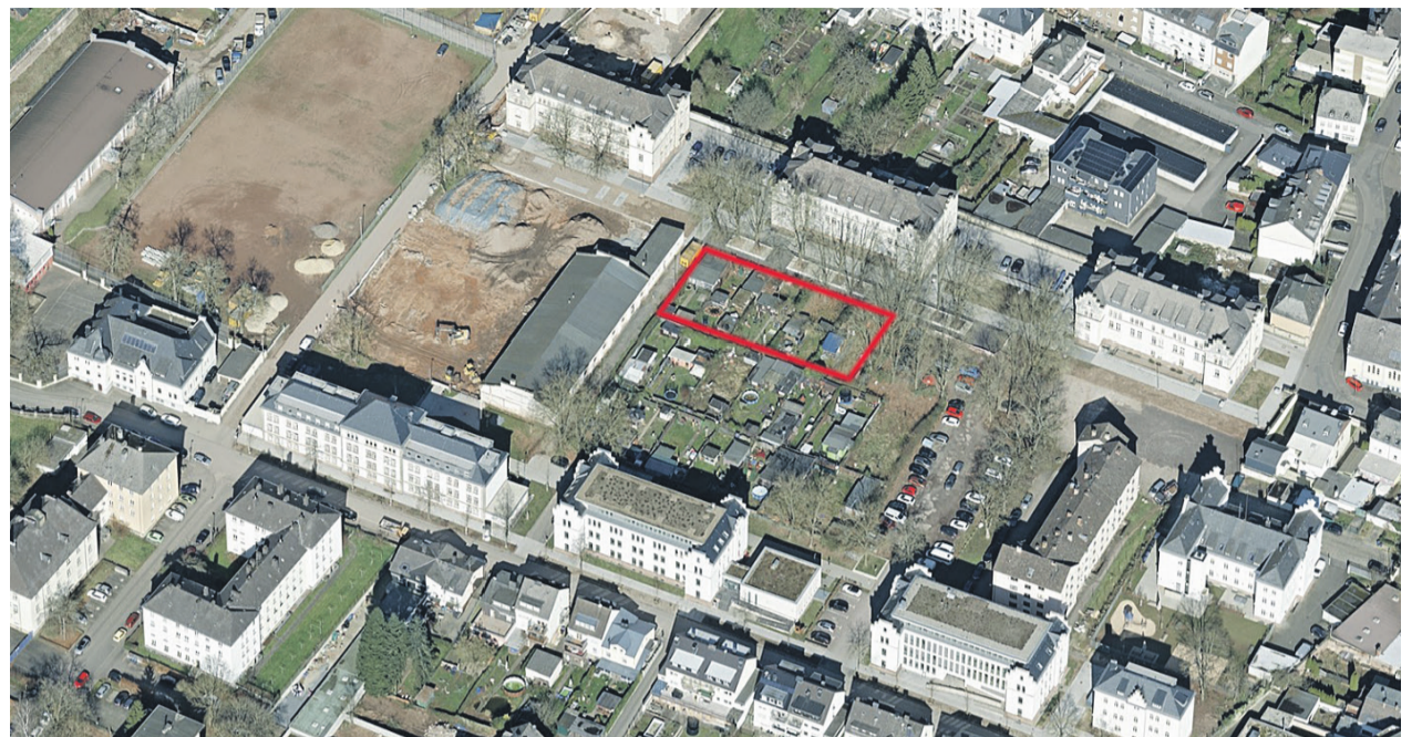
Im Karree. Luftbild des Gneisenauviertels mit den Mietergärten im Zentrum. Fünf Parzellen (rot markiert) werden ab Oktober geräumt. Das querstehende Gebäude rechts von den Gärten wurde inzwischen abgerissen.
