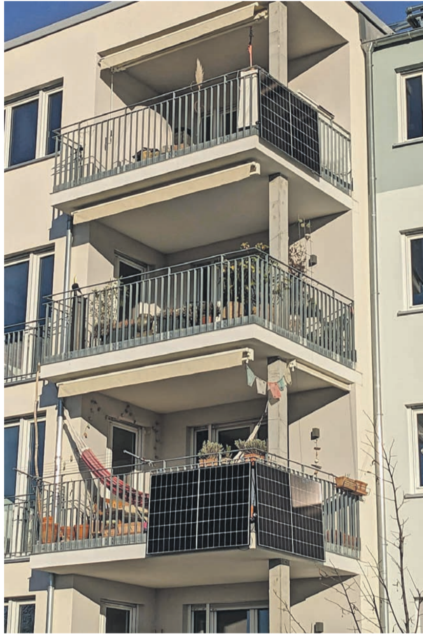
Sonnig. An günstig ausgerichteten Balkongeländern eines Mehrfamilienhauses wird Solarenergie gewonnen. Foto: Rudy23/Creative Commons BY-SA 4.0
