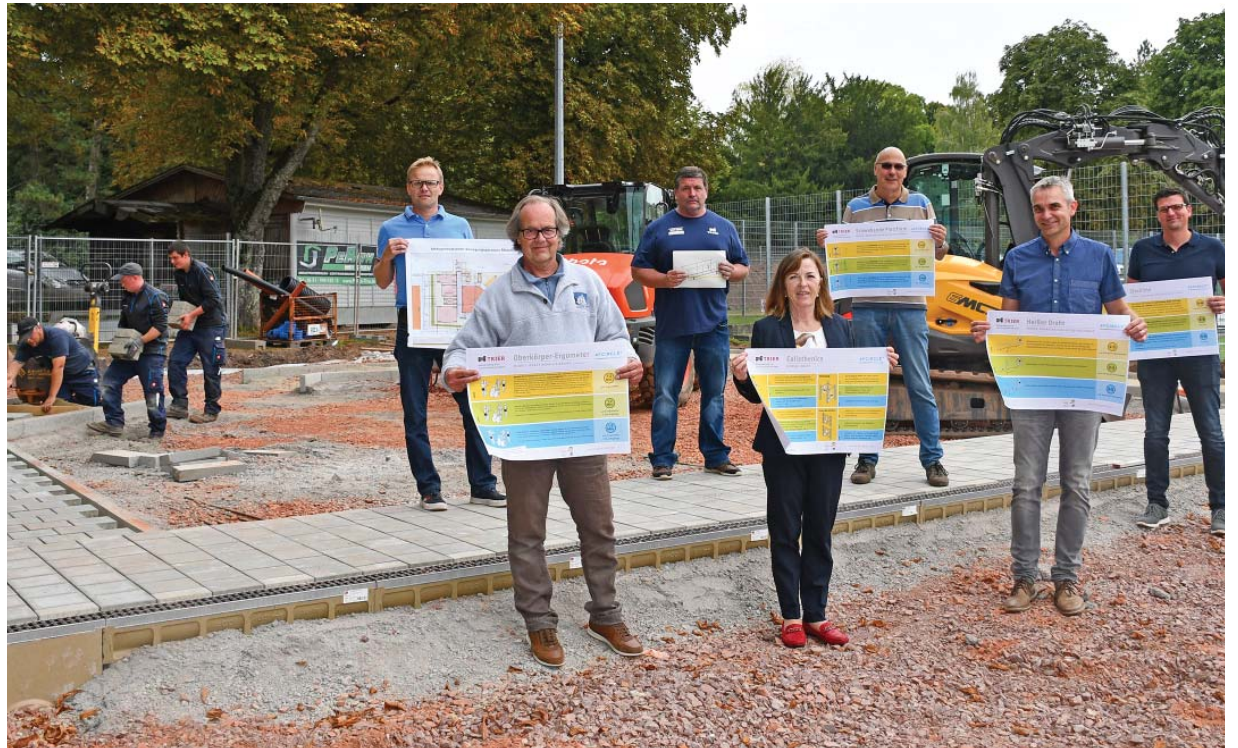
Auf der Baustelle. Bürgermeisterin Elvira Garbes freut sich gemeinsam mit dem Ortsvorsteher von Trier-Nord, Dirk Löwe (vorne, l.), und Matthias Ulbrich vom Amt für Schulen und Sport (vorne, r.) sowie weiteren Beteiligten, dass die Arbeiten zum Bau des Bewegungsparcours im Moselstadion gut vorangehen. Foto: Presseamt/gut
