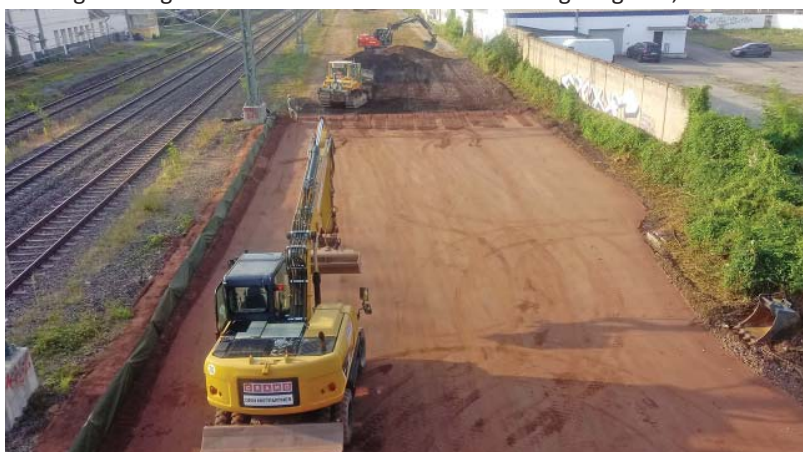
Verdichtet. Der grüne Schutzzäun (links) verhindert, dass die Eidechsen auf die spätere Straßenbaufläche zurückkehren. Die Übersteighilfen für Nachzügler müssen in diesem Abschnitt noch installiert werden. Foto: PA/kig
