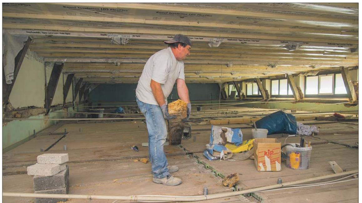
**Angepackt.** Auf der Baustelle unter dem Turnhallendach der Barbaraschule räumt Alexandro Comerzan einen morschen Stützbalken zur Seite. Die Zwischensparren der Decke sind gedämmt und mit einer Dampfbremssfolie abgedeckt. Foto: PA
