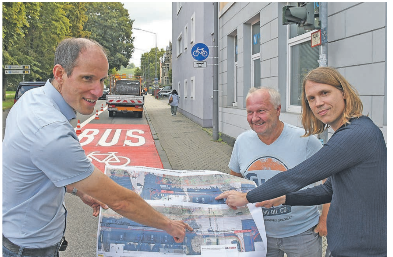
Vor Ort. Beigeordneter Dr. Thilo Becker (l.) tauscht sich mit Verkehrsplaner Jonas Klöpfer (r.) und Bauleiter Georg Gulla (Mitte) über den Fortschritt der Markierungsarbeiten für die Umweltspur in der Südallee aus. Fotos: Presseamt/kg
