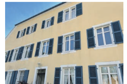
Markenzeichen. Das Weingutsgebäude im Ruwertal hat auch durch seine markante historische Fassade einen hohen Wiedererkennungswert.
