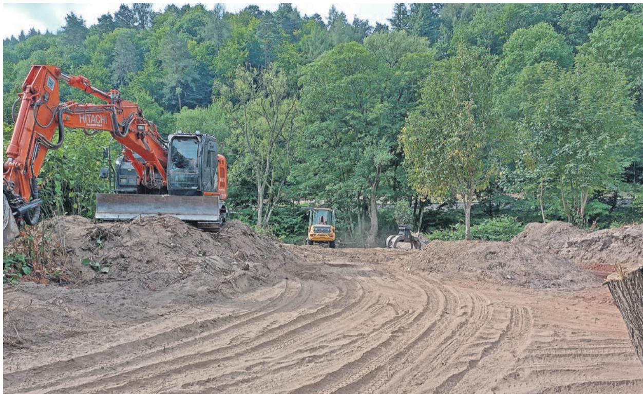
Sandarbeit. Die Baumaschinen haben es auf der Kyllinsel mit beträchtlichen Mengen Erdmaterial zu tun, das sich während des Hochwassers angesammelt hatte. Foto: StadtRaum Trier
