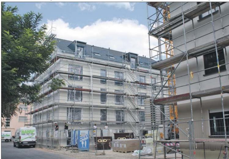
**Neubau.** Ein Projekt im Sozialen Wohnungsbau wird derzeit im Auftrag der Firma Imprinzip GmbH & Co. KG an der Ecke Hohenzollern-/Franz-Altmeier-Straße realisiert. Knapp ein Jahr nach dem Spatenstich werden die Fassaden der beiden Gebäude, in denen 34, zwischen 49 und 95 Quadratmeter große Wohnungen entstehen, verputzt. Zudem läuft der Innenausbau. Foto: Presseamt/pe
