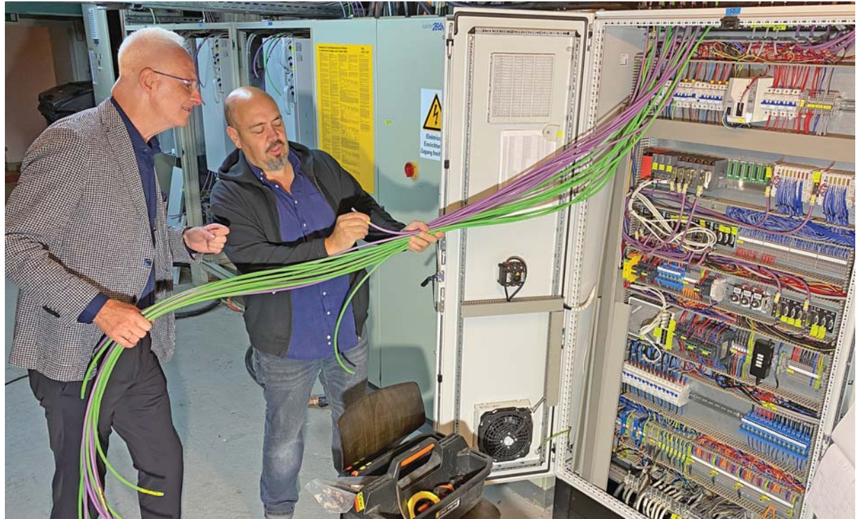
Kabelsalat. Theatermitarbeiter Joachim Schmitt (rechts) erläutert OB Wolfram Leibe Details der Bühnenmaschinerie, durch die Podien auf der Bühne im Boden versenkt oder hochgefahren werden können. Foto: Presseamt/mic
