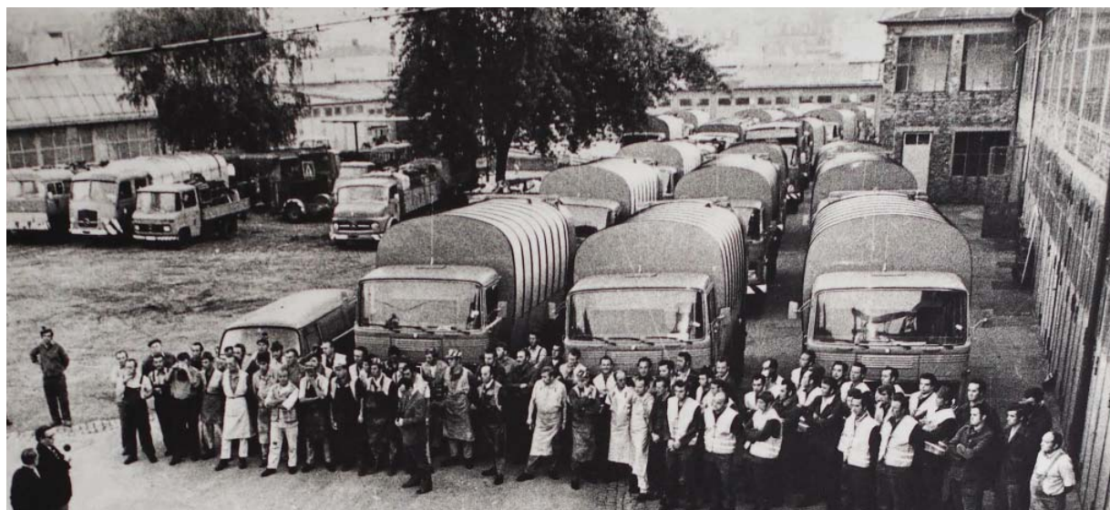
Neues Team. Die Belegschaft des frisch gegründeten Zweckverbands präsentiert sich 1973 mit ihrem Fuhrpark auf dem Betriebsgelände an der Löwenbrückener Straße in Trier-Süd. 50 Jahre später wird dieser innenstadtnahe Standort nach und nach aufgegeben.
