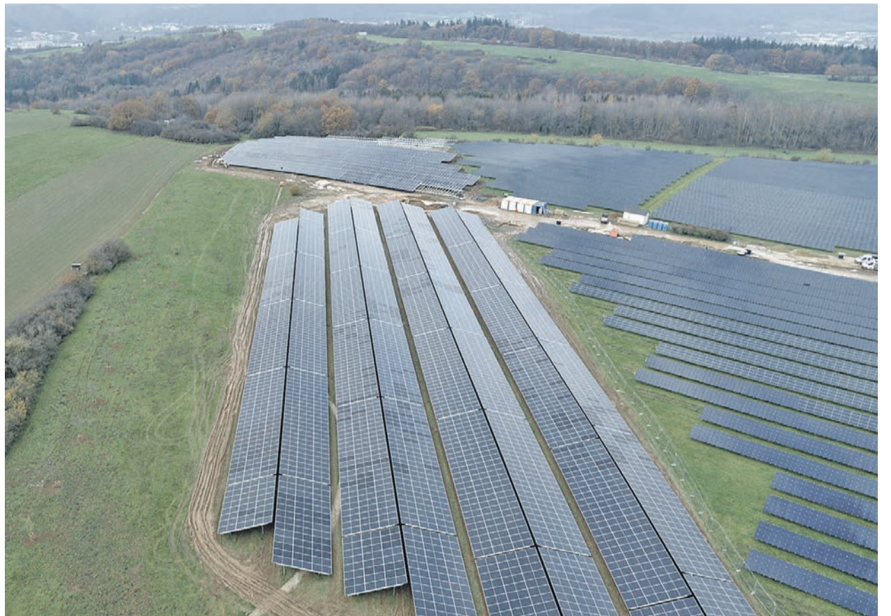
Flexibel. Das Luftbild zeigt die Ausrichtung der Module des Solarparks in verschiedene Richtungen. Dadurch verbessert sich die Stabilität der Stromproduktion. Foto: Stadtwerke
