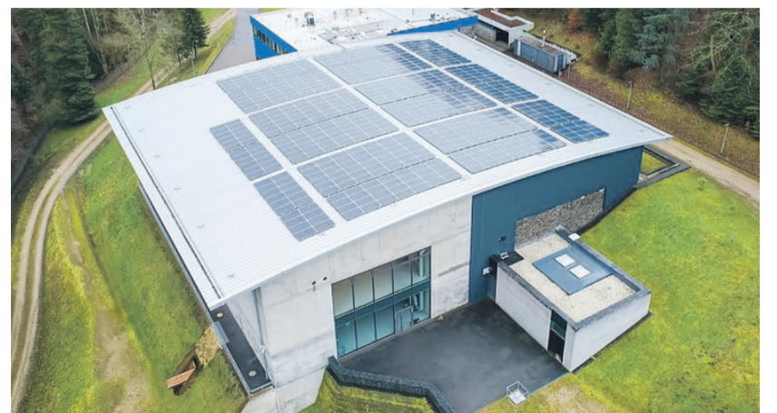
Autark. Rund 1,7 Millionen Kilowattstunden Strom benötigen die Stadtwerke pro Jahr allein für die Trinkwasserversorgung in Trier. Schon seit Dezember 2020 wird dieser Bedarf komplett selbst gedeckt durch Photovoltaikanlagen, unter anderem auf dem Wasserwerk Irsch. Archivfoto: SWT
