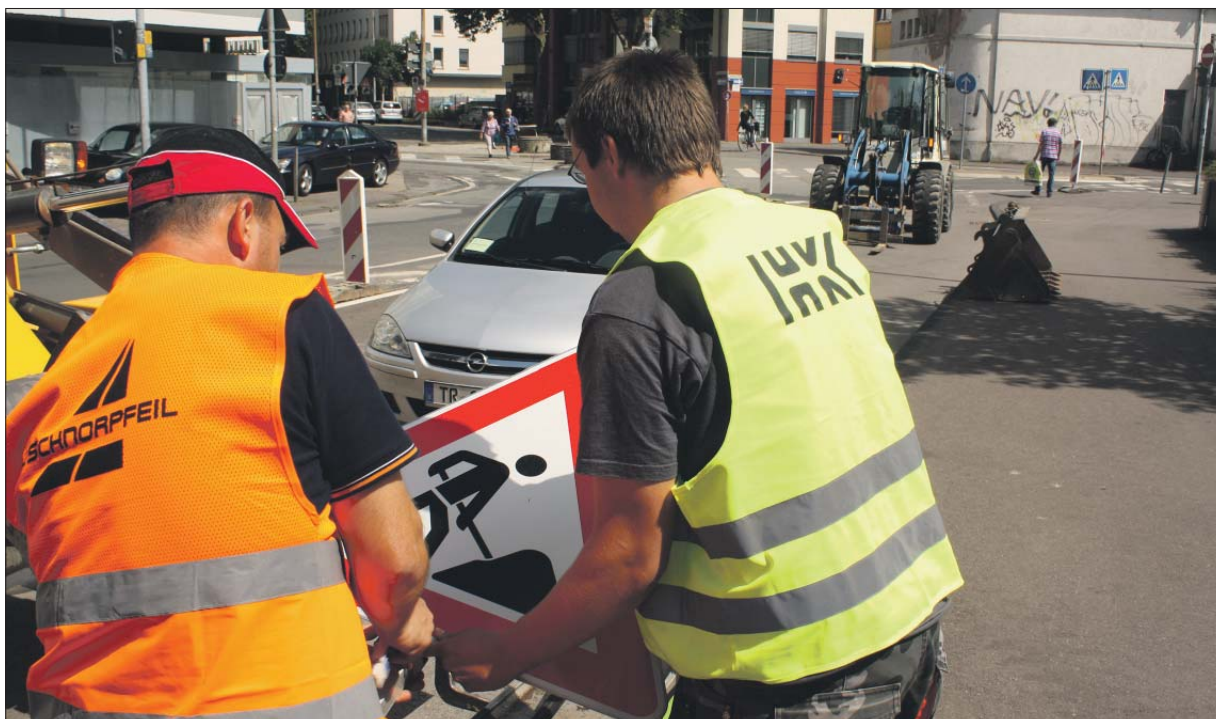
Beschilderung. Mitarbeiter der AG Schnorpfel/Köhler richten die Baustelle am Pferdemarkt ein.
