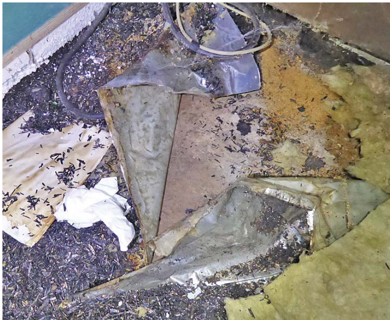
Böse Überraschung. In der Wolfshalle wurden 2019 hinter der Wandverkleidung und im Boden Feuchtigkeitsschäden mit Schimmel entdeckt. Fotos: Büro Gasthauer
