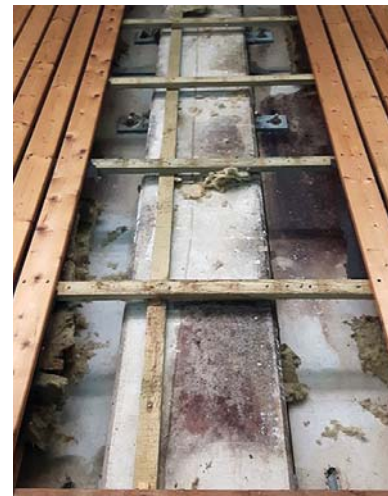
Böse Überraschung. In der Wolfshalle wurden 2019 hinter der Wandverkleidung und im Boden Feuchtigkeitsschäden mit Schimmel entdeckt. Fotos: Büro Gasthauer
