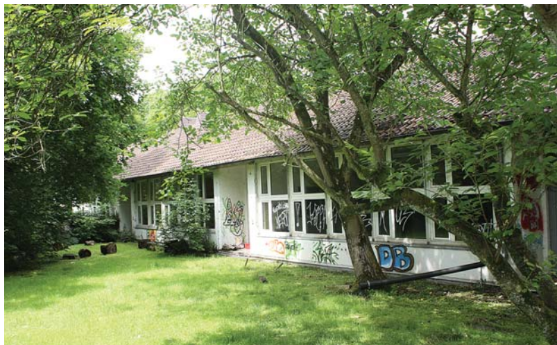
Stillstand. Das vom einer großen Grünfläche mit vielen Bäumen umgebene Gebäude der Egbert-Grundschule kann wegen seines schlechten baulichen Zustands schon seit mehreren Jahren nicht mehr genutzt werden. Die Kinder werden bis zum Abschluss der noch nicht gestarteten Generalsanierung in der früheren Grundschule Kürenz unterrichtet. Archivfoto: PA/pe
