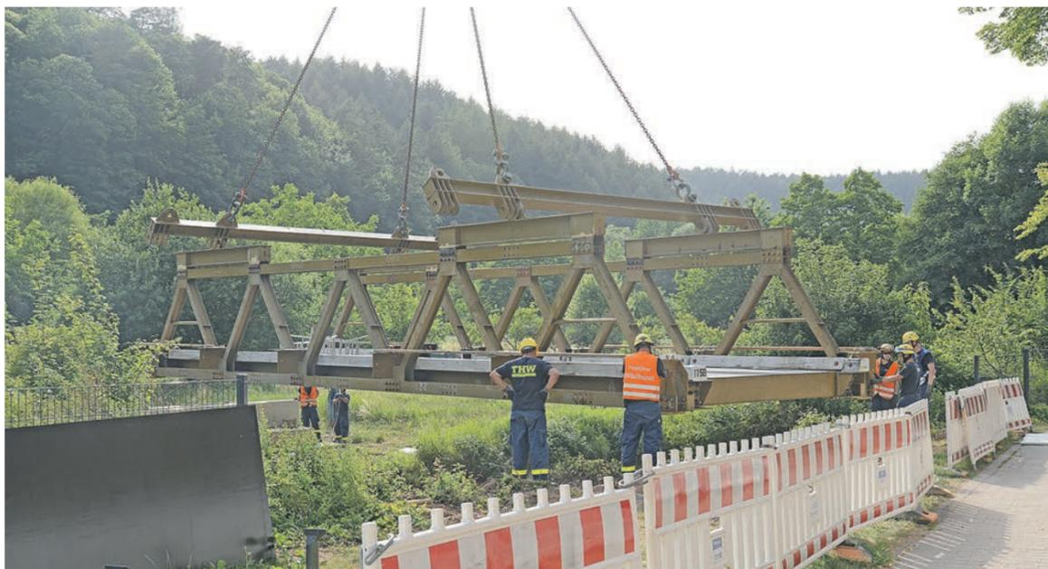
**Am Haken.** Fachleute des THW nehmen die vormontierte Brücke, die mit einem Kran von der Straße ans Flussufer gehievt wird, „in Empfang“.
