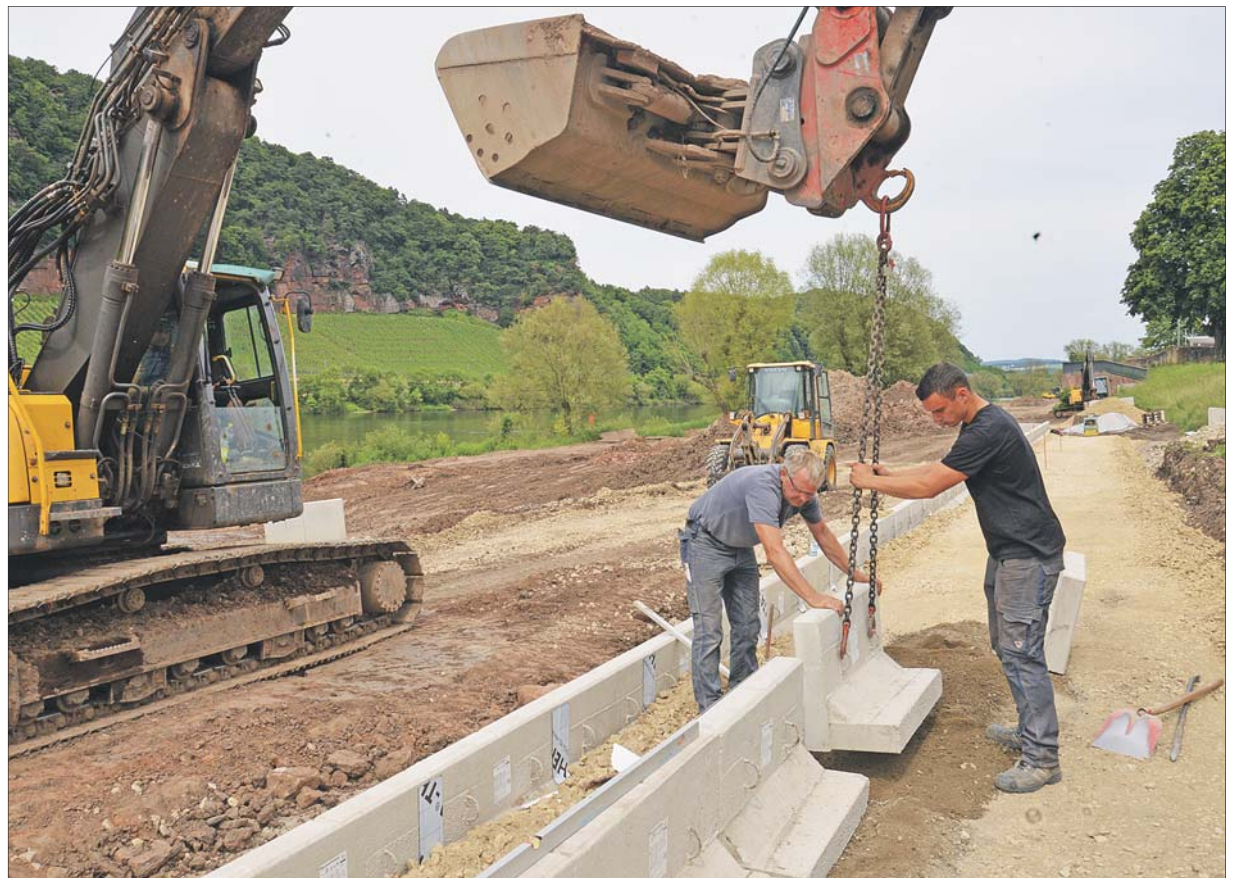
Stück für Stück. Mitarbeiter der Firma Wacht platzieren am Moselufer in Trier-Nord Stützelemente für Sitzstufen und Treppen mit einer Gesamtlänge von rund 340 Metern in acht Reihen. Foto: Presseamt/kg
