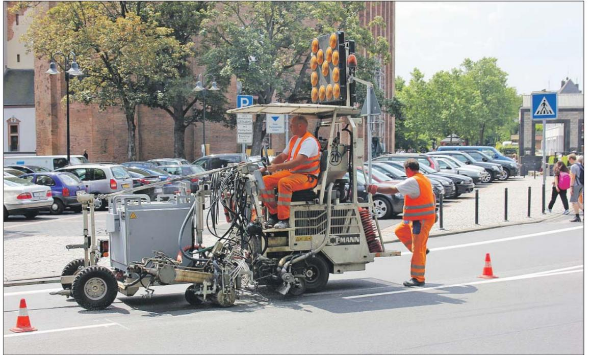
**Striche und Linien.** Arbeiter tragen mit einem Spezialgerät die neue Fahrbahnmarkierung in der Mustorstraße auf. Die Asphaltdecke der Straße war bereits im März erneuert worden. Foto: PA
