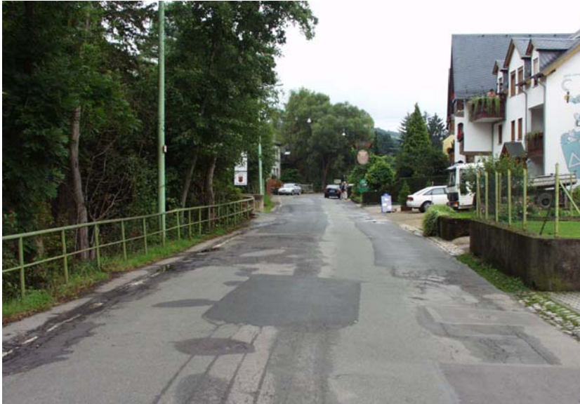
Abb. 11: Oleviger Straße 3. Bauabschnitt
