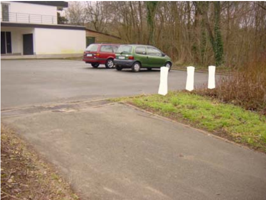
Abbildung 30: Absperrung herkömmlicher Art
